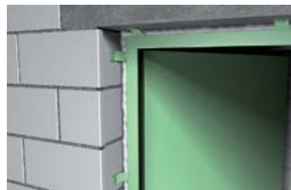
Герметизация стальных дверных коробок
