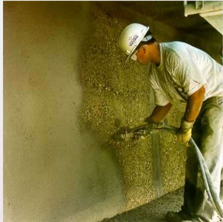
Нанесение распылением VANDEX UNI MORTAR 1 Z
