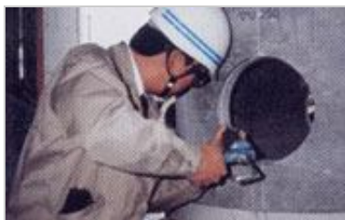
Для швов отливки монолитного бетона
