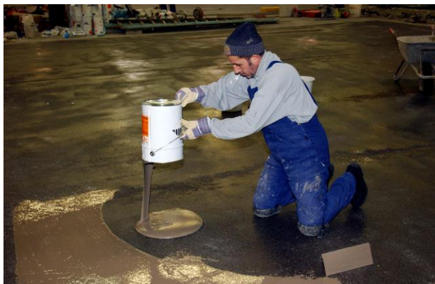
Применение гидроизоляции PCI Apoflex F
