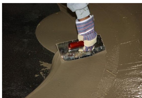
Укладка PCI Aproflex на прогрунтованное основание
