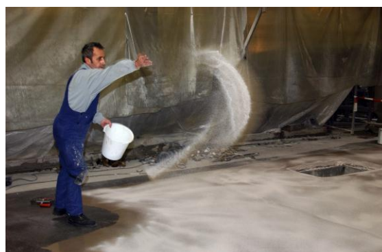
Посыпка песком грунтовки PCI Eproxigrund 390
