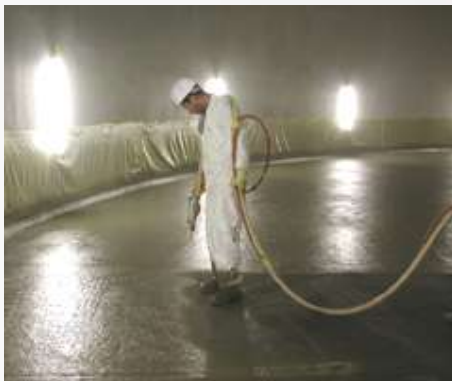
3) Распыляем материал VANDEX на пол
