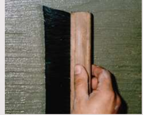
3) Текстурирование первого слоя для идеальной адгезии второго слоя
