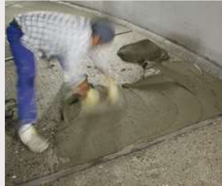
2) Наносим обмазочный состав VANDEX MORTAR на пол
