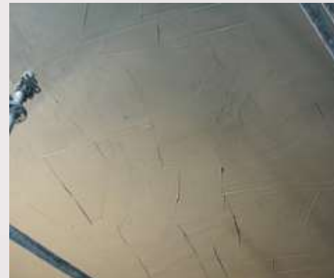
2) Наносим обмазочный состав VANDEX MORTAR на пол
