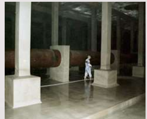
6) Обзор готового резервуара
