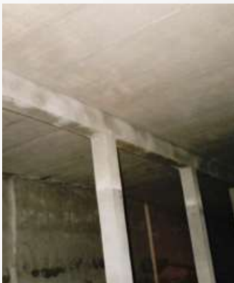
4) Готовый потолок, покрытый раствором VANDEX BB 75
