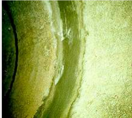
2) Остановка утечек воды из шов трубопровода с помощью заглушек VANDEX
