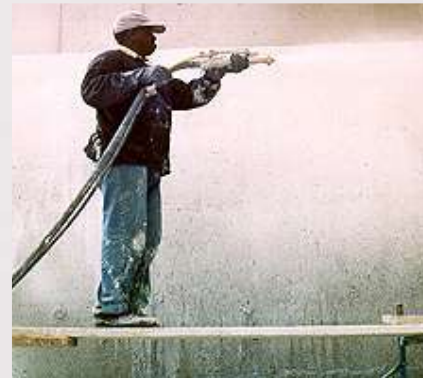
4) Распыление состава VANDEX BB WHITE, 6 кг/м 2 (3 мм)
