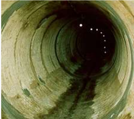
1) Водопровод протяженностью 65 км диаметром 2,5 м
