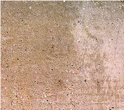
3) Хорошо подготовленная бетонная поверхность незадолго до получения обработки Vandex
