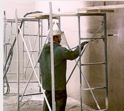
2) Подготовка поверхности с использованием воды под давлением
