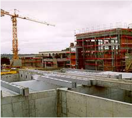
1) Обзор площадки Alcantarilha Water Очистные сооружения в стадии строительства
