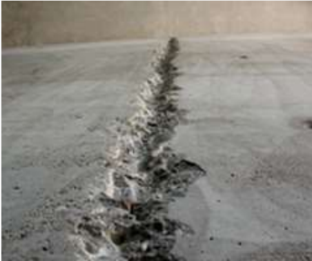
1) Подготовить поверхность, расшить строительные швы
