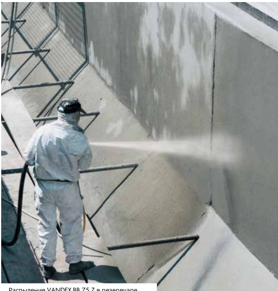
Распыление VANDEX BB 75 Z в резервуаре
