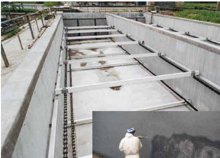
Распыление VANDEX POLYCEM Z
