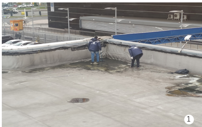
Рис.1 Очистка поверхности от воды и грязи.
