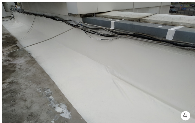
Рис.4 Нанесение гидроизоляции ENDURIS® валиком в 1 слой.
