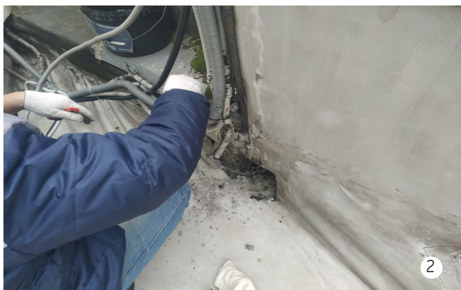
Рис.2 Удаление грязи из водостока.
