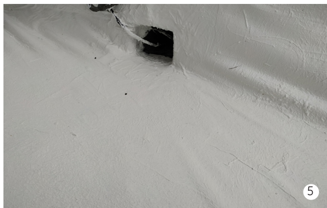
Рис.5 Обработка водостока покрытием ENDURIS®.
